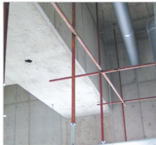
〈CANOTILE 설치 상세도 : SQ-BAR공법〉
