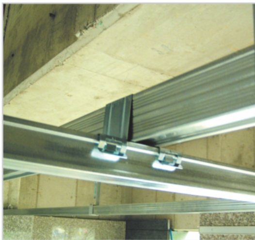
〈CANOTILE 설치 상세도 : SQ-BAR공법〉
